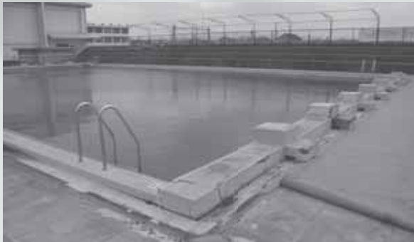
揖保川中学校屋外プール
