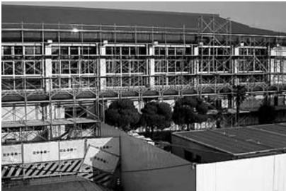
耐震補強工事中の揖西小体育館
