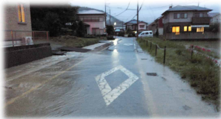
台風による浸水被害（新宮町新宮）
