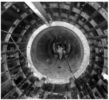
▶仕上げコンクリート (仕上げり内径2.8m)
