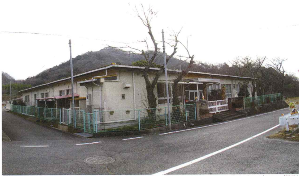
北西方より撮影
