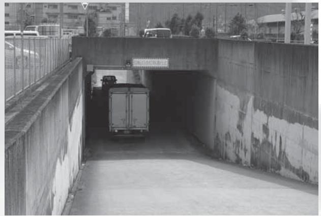
LED灯に交換する国道2号線地下道(揖保町)
