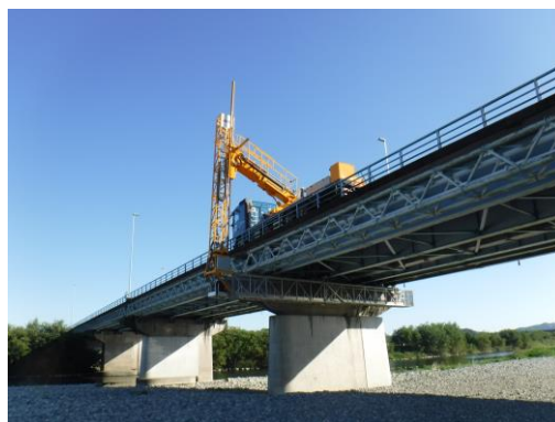
■橋りょう点検
