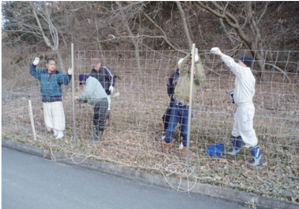
防護柵の設置
