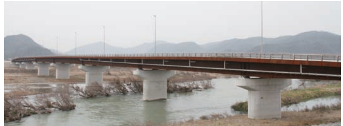
揖龍南北幹線道路（たつの大橋）
