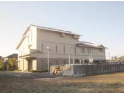
龍野西浄化センター
