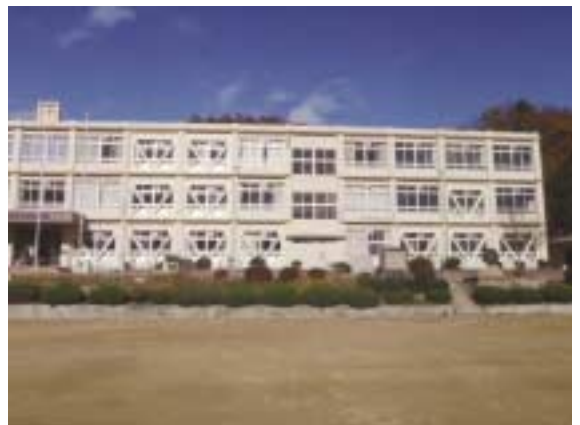
学校施設の耐震補強
