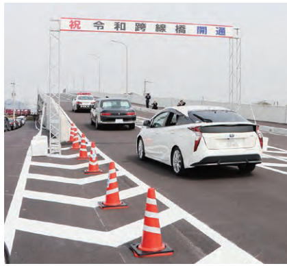
新たに完成した令和跨線橋
