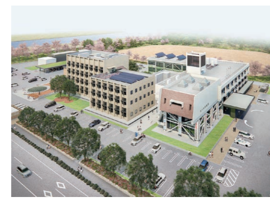
本庁舎改築工事の実施
