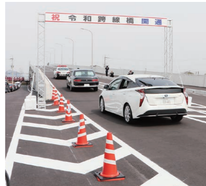
新たに完成した令和跨線橋
