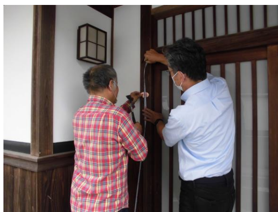
設置作業の様子
