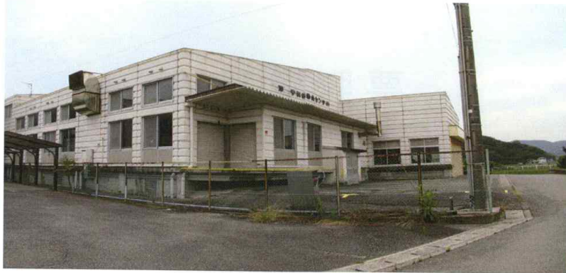
北東方より撮影
