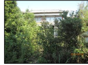
敷地内の立木・雑草が敷地を越えて繁茂
