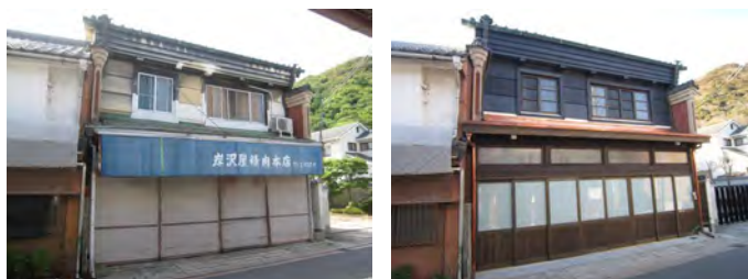
重伝建地区内の修理事例(左：修理前、右修理後)
