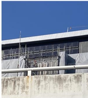
建物壁面への実装工事の様子
