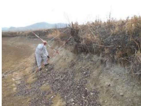
堤体の浸食状況等の点検
