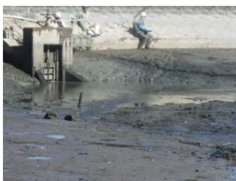
泥土除去後の状況(かいぼり実施後)
