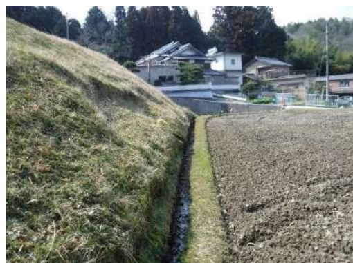
後法 はらみだし及び陥没
