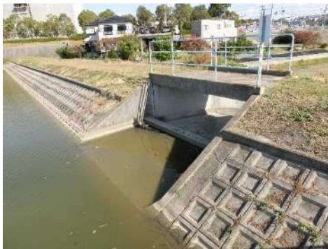
洪水吐(上流側)
