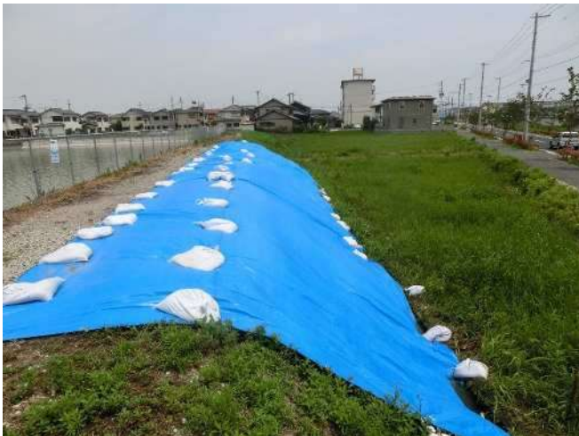
堤体下流法面にブルーシート設置
