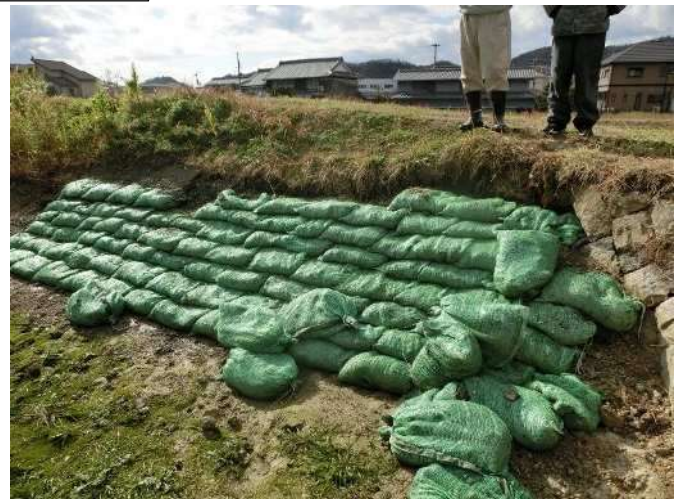
堤体上流法面に土のう設置
