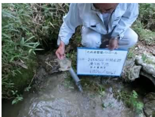
後法 漏水量測定(遠景)
