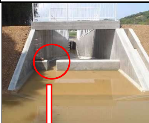
【南あわじ市 洪水吐越流堰の切欠き】
