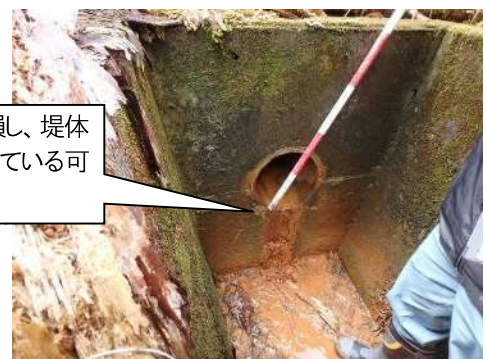
底樋出口(堤体下流)
