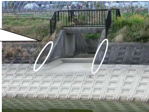
洪水吐(貯水池側より)
