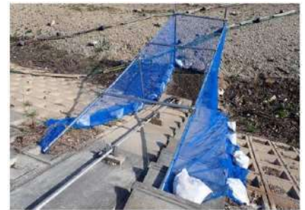
取水施設周りに防風ネットを設置
