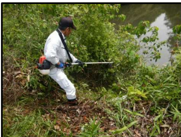
ため池前法での草刈作業の様子
