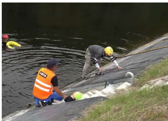
法面にネットの設置
