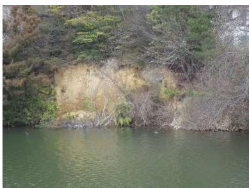
ため池周囲 土砂崩壊
