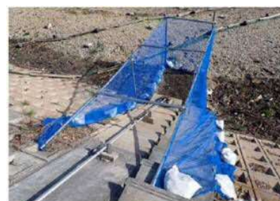
取水施設周りに防風ネットを設置
