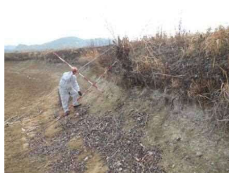
堤体の浸食状況等の点検
