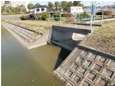
洪水吐(上流側)
