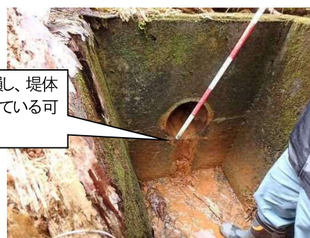
底樋出口(堤体下流)
