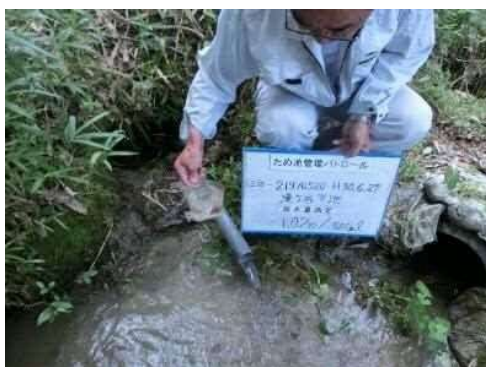
後法 漏水量測定(遠景)
