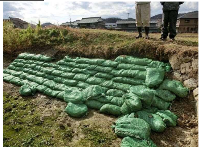
堤体上流法面に土のう設置
