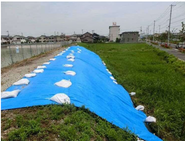
堤体下流法面にブルーシート設置
