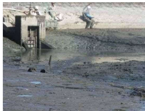
泥土除去後の状況(かいぼり実施後)
