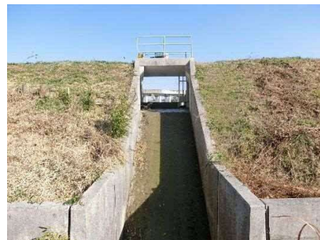
洪水吐(下流側)
