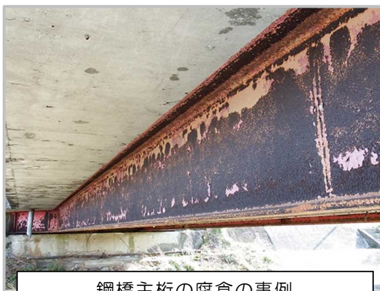
鋼橋主桁の腐食の事例
