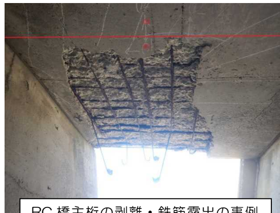
RC 橋主桁の剥離・鉄筋露出の事例
