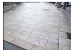
石張舗装 (門の外地区)
