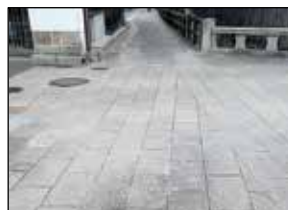
石張舗装 (上川原地区)
