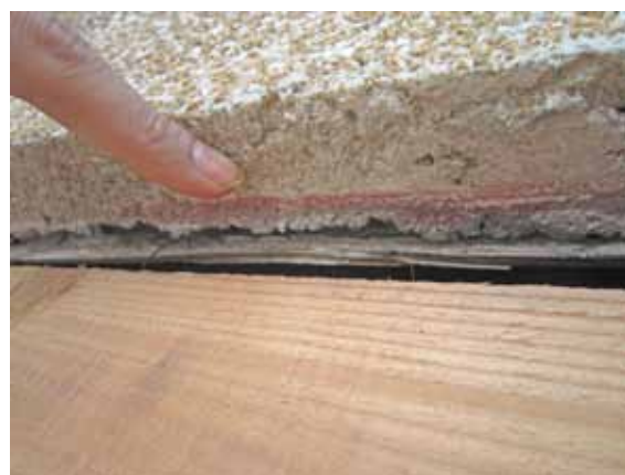
袖卯建北面の洗出し壁にタイル痕が残る
