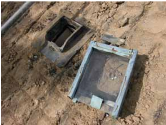
天窓解体前。板金仕上の蓋を被せていた
