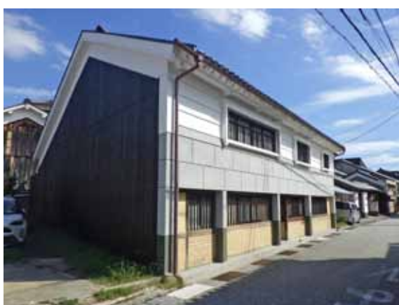
写真3 下屋庇を復原せず、「外観の現状維持」を選択した事例
