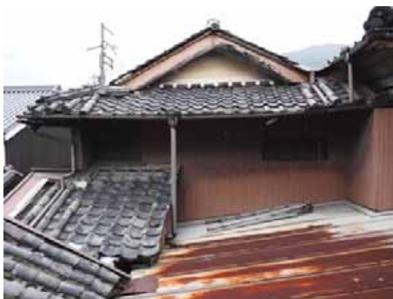
c 棟南面（修理前）
