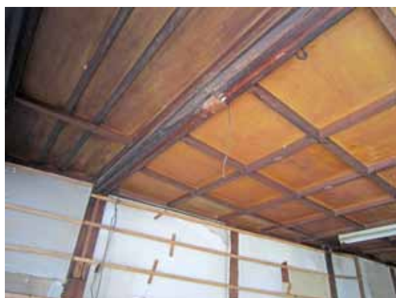
1 階通り側の柱に欄間跡が残る
