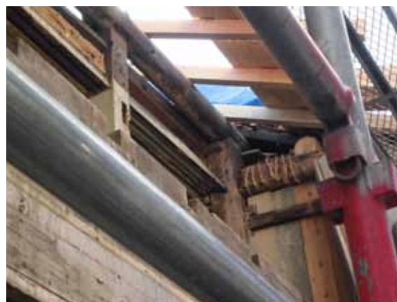
軒桁、腕木に漆喰塗籠痕が残る
