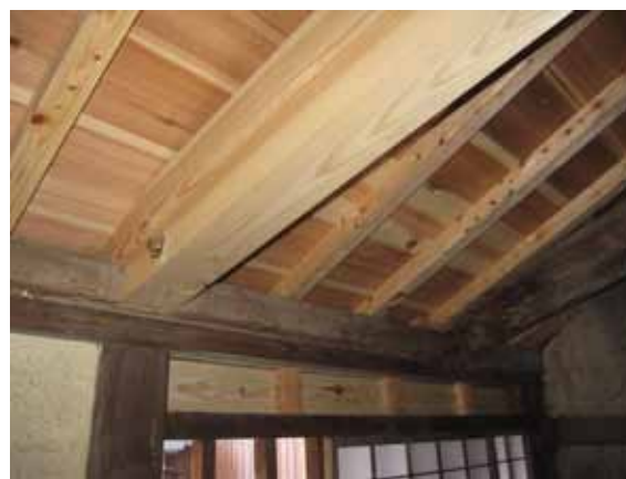
既存梁の横に登り梁を新設
