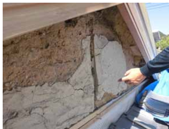
痕跡に基づき漆喰塗り仕上げで復原
