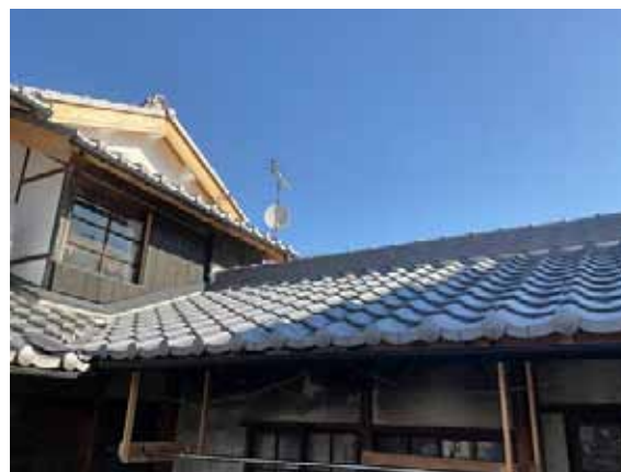
腐食箇所を取り替え、棧瓦葺きで復原
