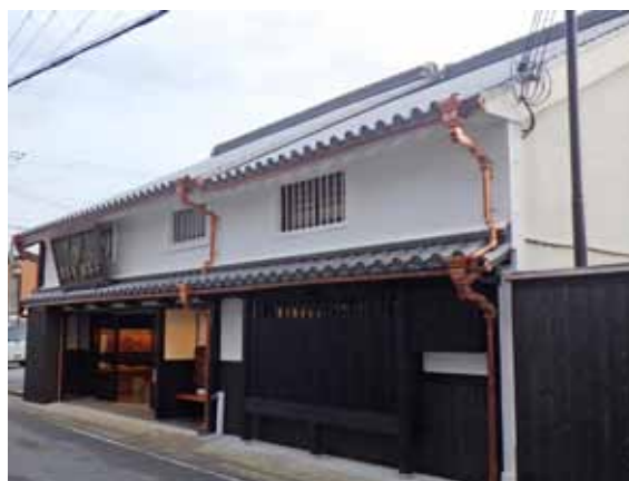
写真2 軒切りされた下屋庇（第二の旧状）を復原した事例
