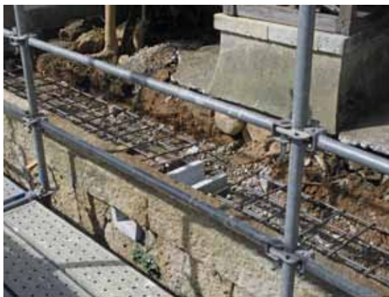
基礎工事状況。湿気対策の水抜雨樋を設置
