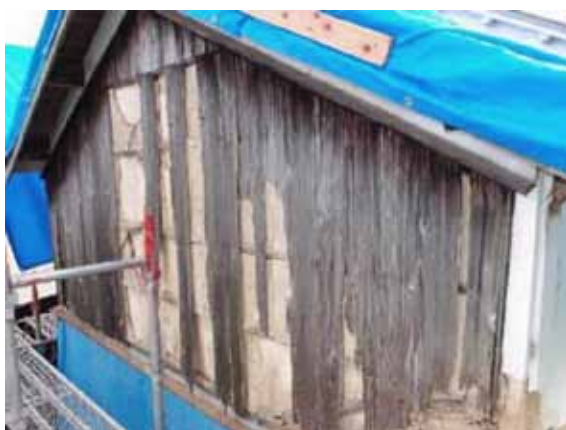
北妻面下に漆喰壁の痕跡が残る
