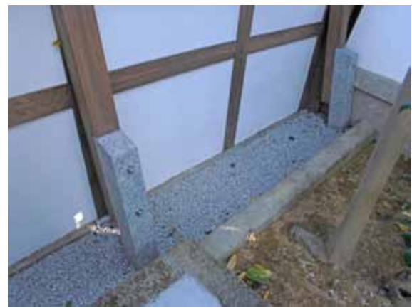
境内の特定物件を参考に、控柱を設置
