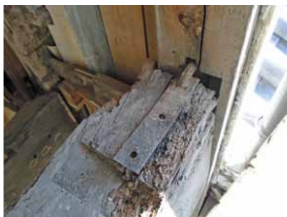
桁梁の高さを変えた際の金具跡
