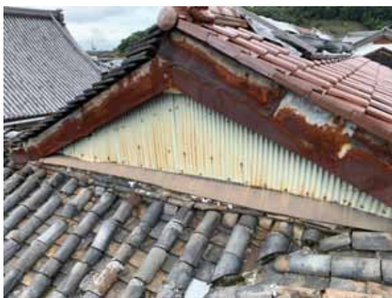
a 棟屋根（修理前）
