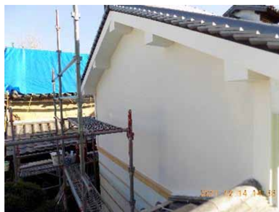
痕跡に基づき漆喰壁で復原
