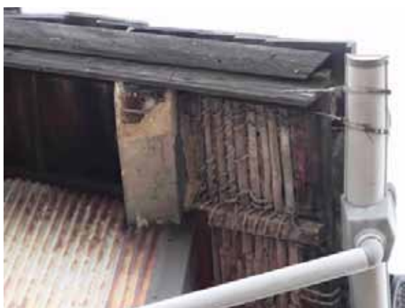
e 棟軒裏に漆喰塗籠の痕跡が残る
