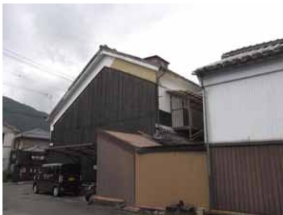
修理前の越屋根（南東方向から）
