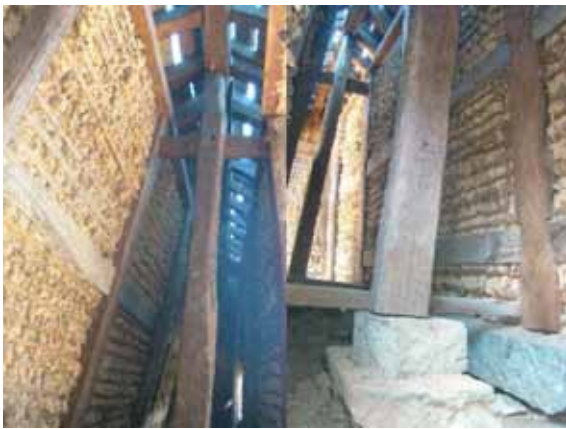
躯体（修理前）。束石、貫のみの構造
