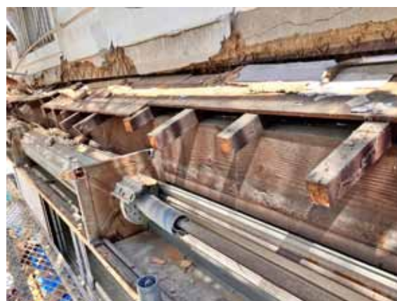
箱底下に軒切りされた垂木が残っていた
