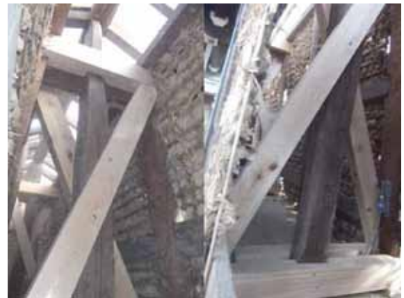
筋違、地覆を追加し構造補強を行った
