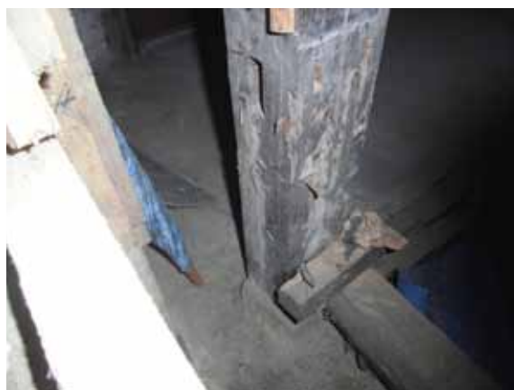
柱に出格子枠をはめるほぞが残る
