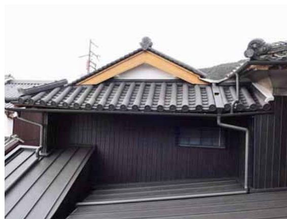
c、d 棟間を径の広い谷樋に取り替えた
