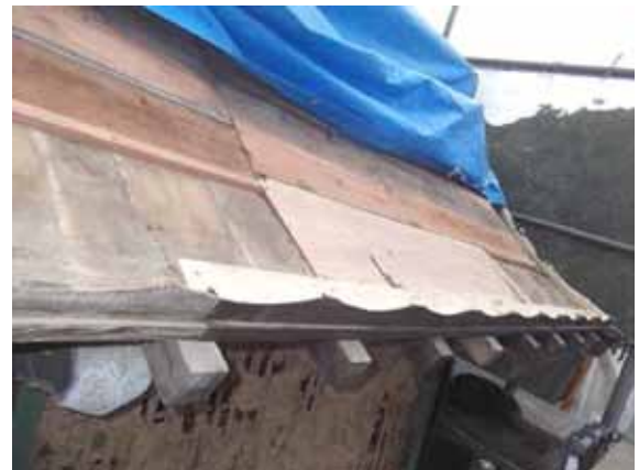
比較的状态の良い部材は再利用した
