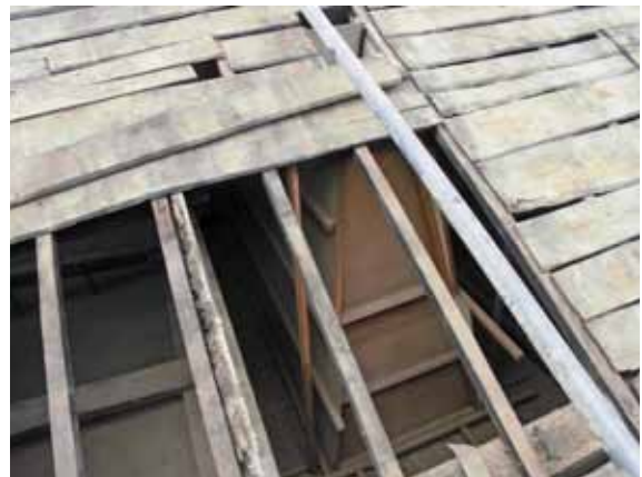
枠材が新しいため天窓は戦後改造と判断
