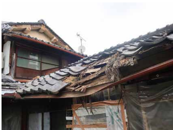
c 棟屋根（修理前）
