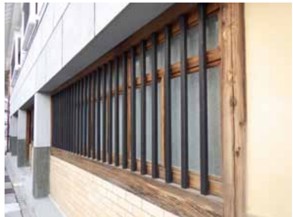
西面木格子（修理後）。松煙塗装で復原
