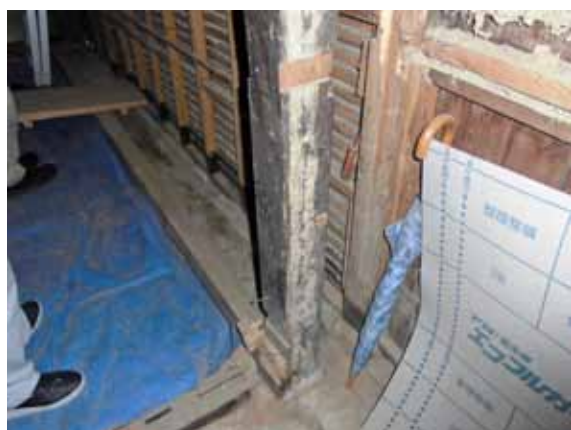
柱の壁土跡から袖壁があったと判断
