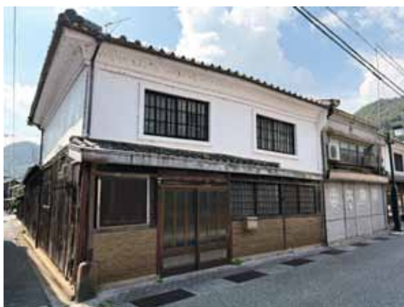
写真1 斜めに軒切りされた龍野町家の事例
