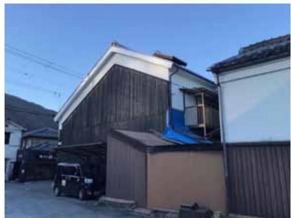
修理後の越屋根（南東方向から）
