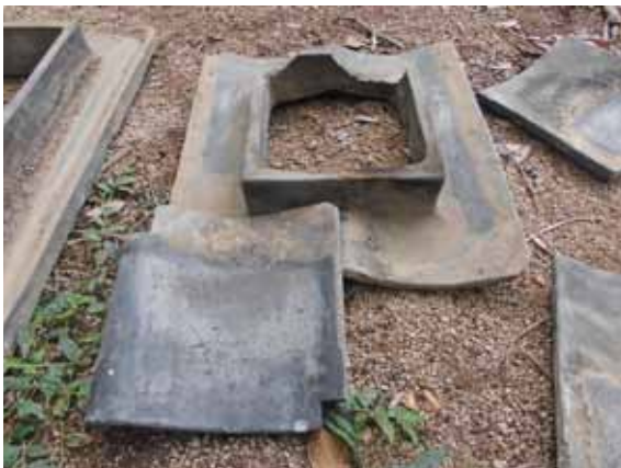
平瓦と天窓瓦の割が合わないため転用と判断
