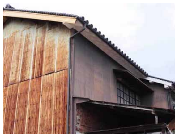
e 棟（修理後）
