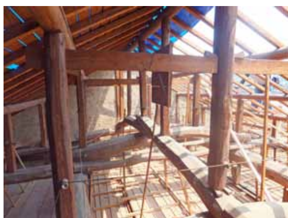
修理中の小屋裏状況
