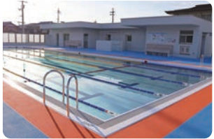
揖西東小学校屋外プール 完成
