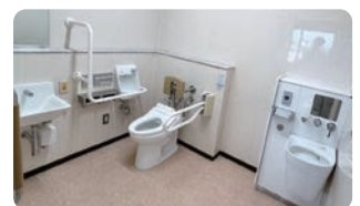
揖西西小学校トイレ改修工事
