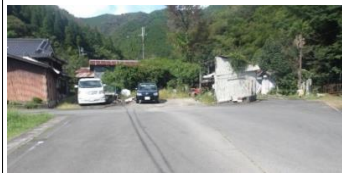
北進道路の終端部分
