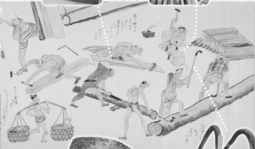
鉋(かんな) 主として材木の表面を けずって加工する目的で 使われる工具の総称。
