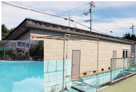
揖西東小学校屋外プール付属棟
