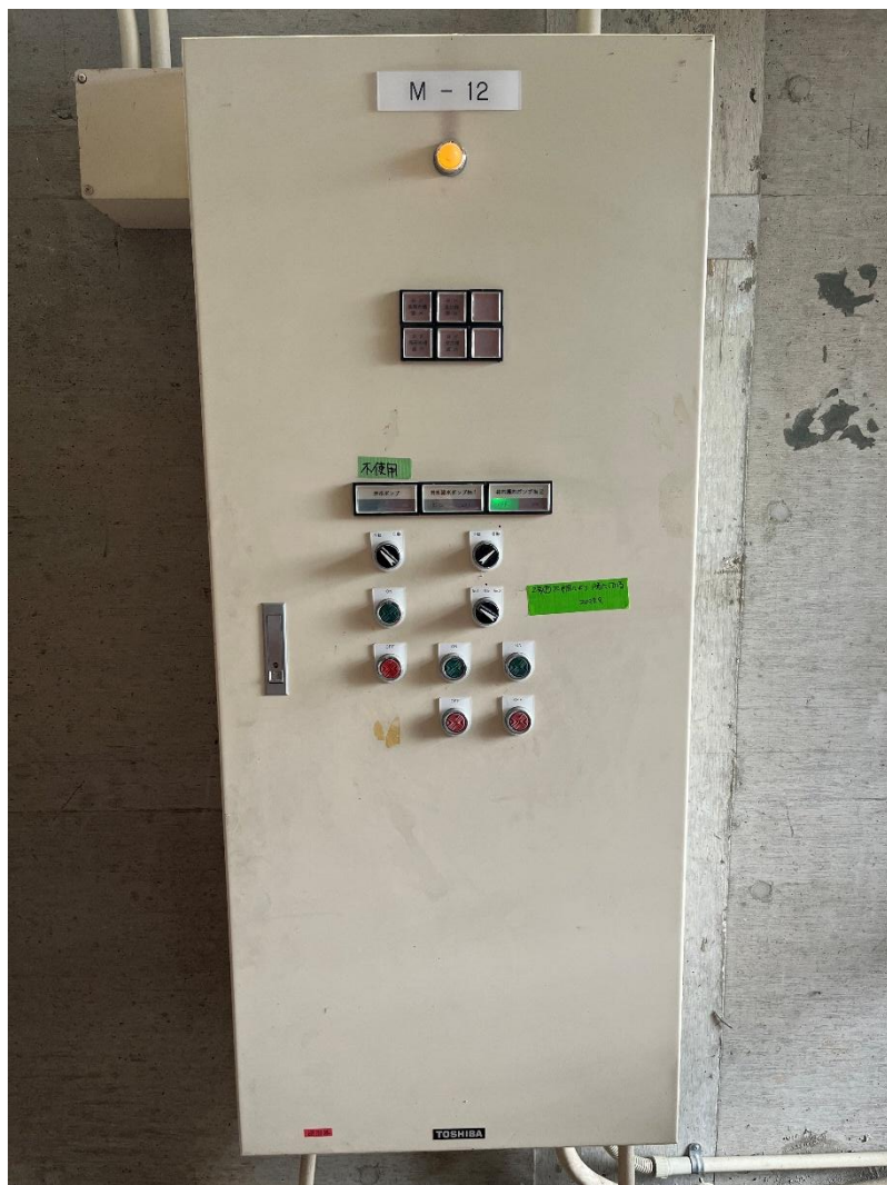
制御盤 1台 (東芝ライティック(株)製) 縦140cm 横60cm 奥行25cm
