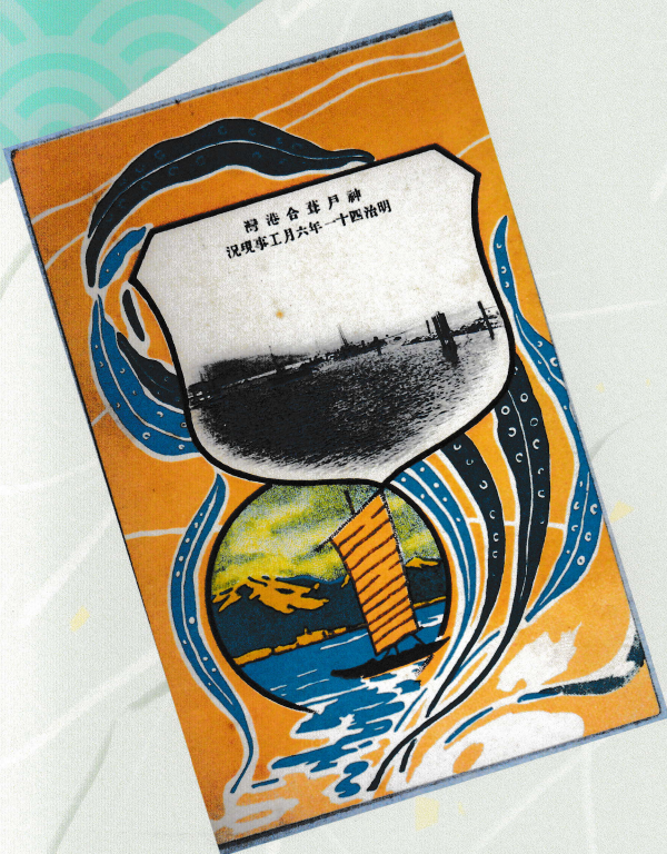
神戸合港湾（明治41年6月工事現況）
