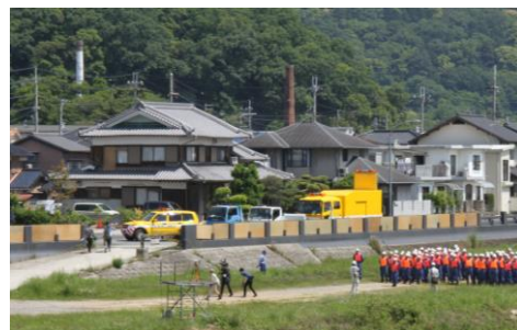
揖保川防災訓練置場設置訓練
