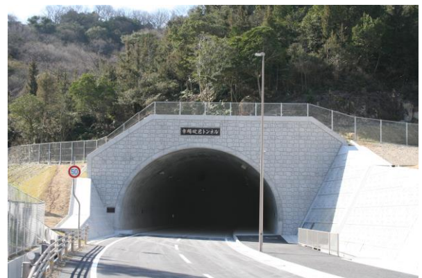
整備された幹線道路（龍野揖保川御津線・市場碓岩トンネル）
