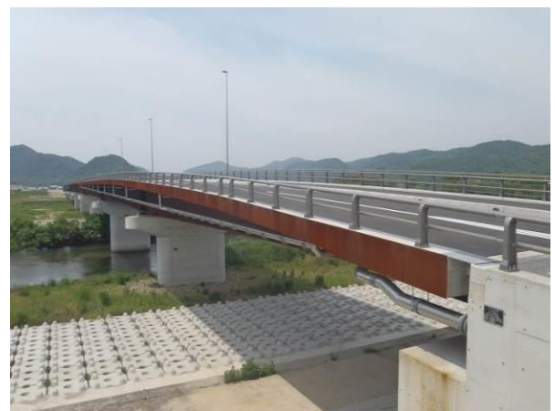
■ 整備された幹線道路（龍野揖保川御津線・たつの大橋）
