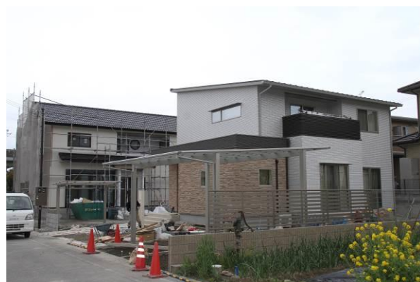
■ 建築が進む住宅
