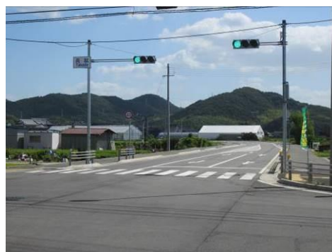
■ 整備された幹線道路(広山高駄線)
