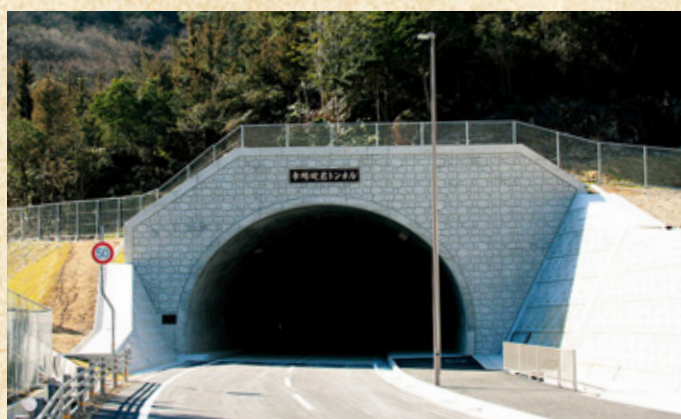
■整備された幹線道路（龍野揖保川御津線・市場碓岩トンネル）
