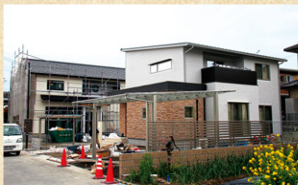
■建築が進む住宅
