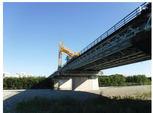
■ 橋りょう点検
