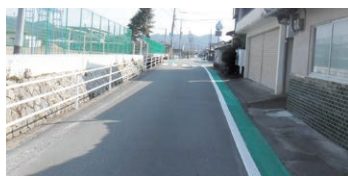
通学路にグリーンベルトを整備
