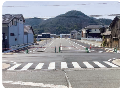
完成した市道竜野駅前南線
