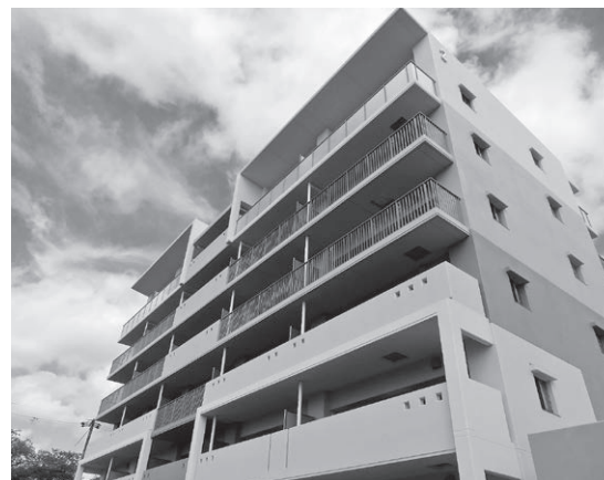
日山住宅新2棟
